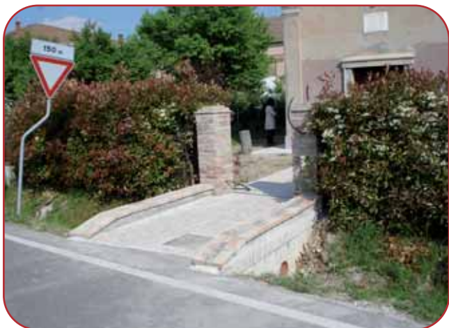
Il nuovo ponticello d'ingresso della chiesa di Albarea (Ferrara)
