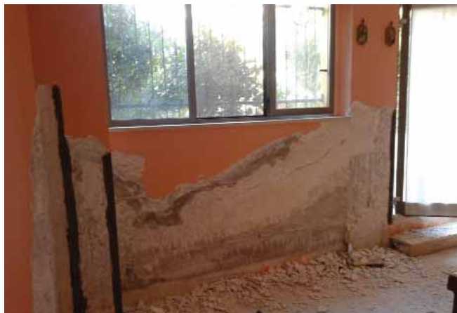
Lavori all'Oratorio di Pescara
